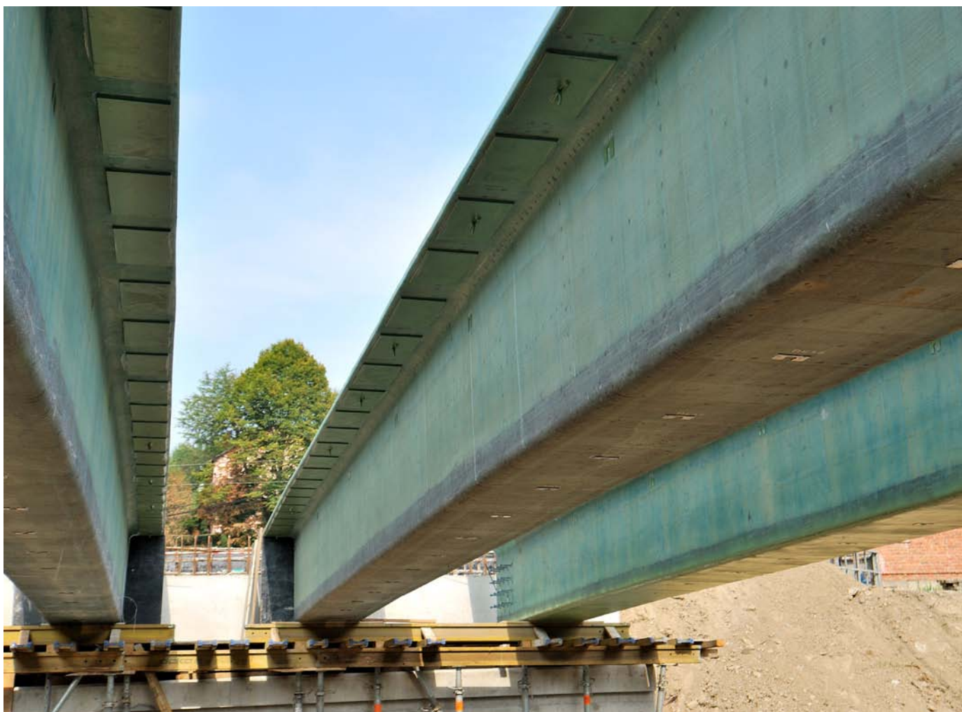
Fot. 2. Most drogowy w miejscowości Błazowa [fot. D. Szczepek]
