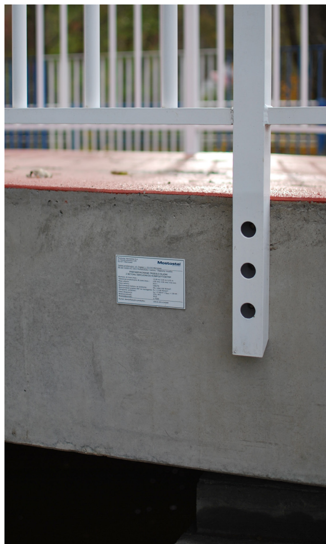
Fot. 4. Przęsło betonowe zbrojone kompozytem [fot. J. Żach]
